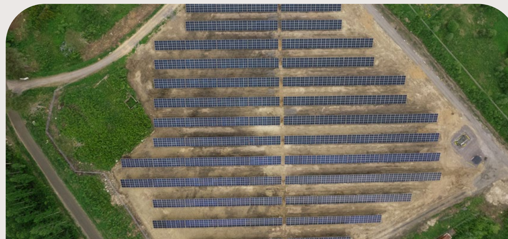
Avointa keskustelua aurinkovoiman rakentamisesta
